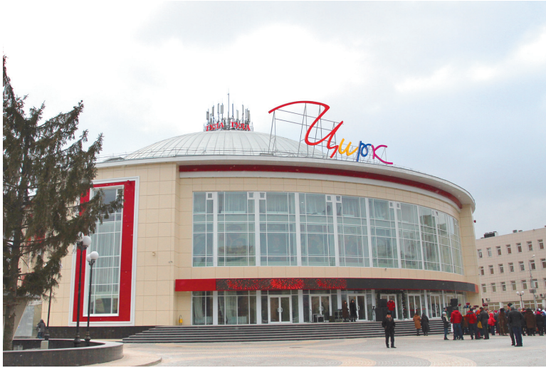
Обновленное здание после реконструкции
