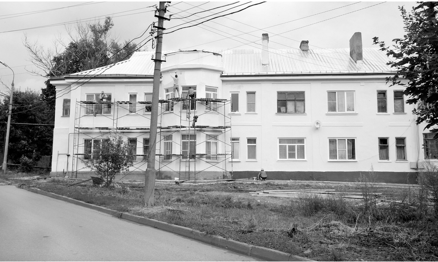
Работы на крыше почти завершены, осталось установить ограждение и водостоки
