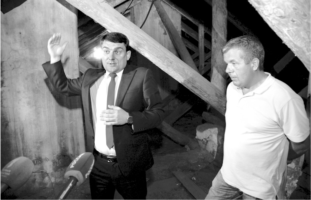
Константин Лопухов (слева): подрядчик аккуратно выполнил капремонт кровли, и теперь протечек быть не должно
