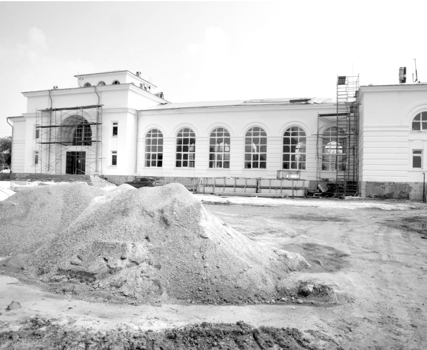
У здания железнодорожного вокзала – горы мучки, щебенки и штабеля тротуарной плитки
