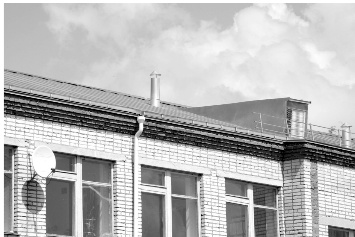
Так выглядит новая кровля в Надеждинской школе
