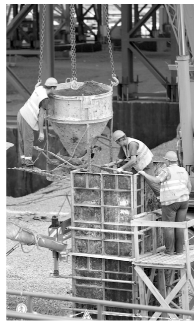
Возведение нового литейно-прокатного комплекса движется скорыми темпами
