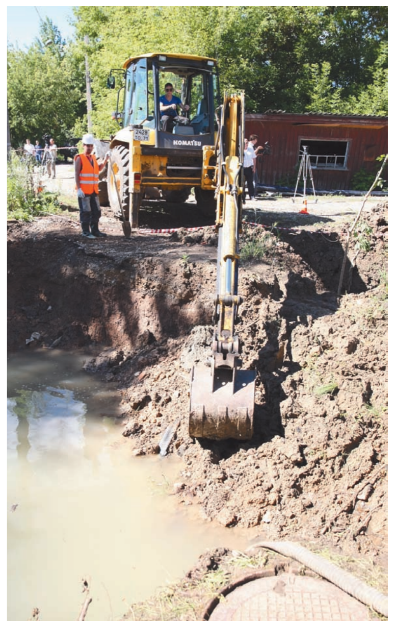
В поселке Ленинский работы по замене труб идут полным ходом
