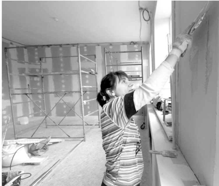
Сейчас в «Перспективе» ремонт идет полным ходом. Старые корпуса просто не узнаешь!
