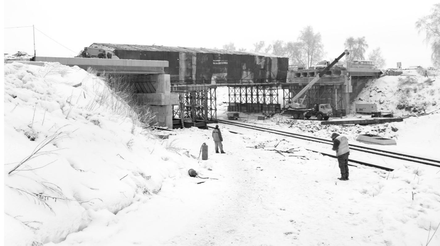
Аварийный средний пролет моста разобран
