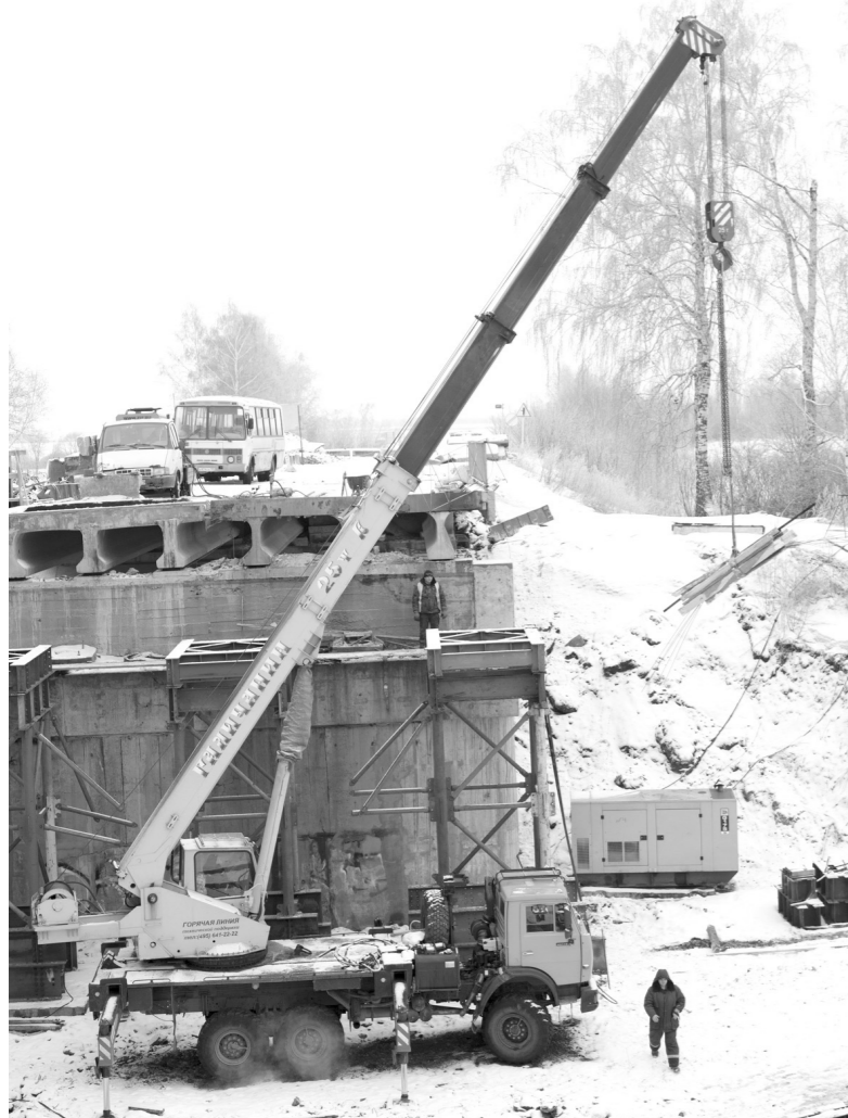
Строители смонтировали вспомогательные опоры, и делаются приспособления, по которым средний пролет будет установлен методом продвижки
