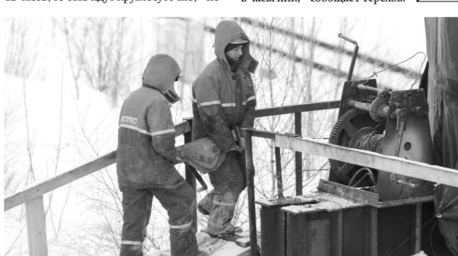
На объекте занято порядка 60 человек — это мостовики, бетонщики. Работы на путепроводке идут круглосуточно
