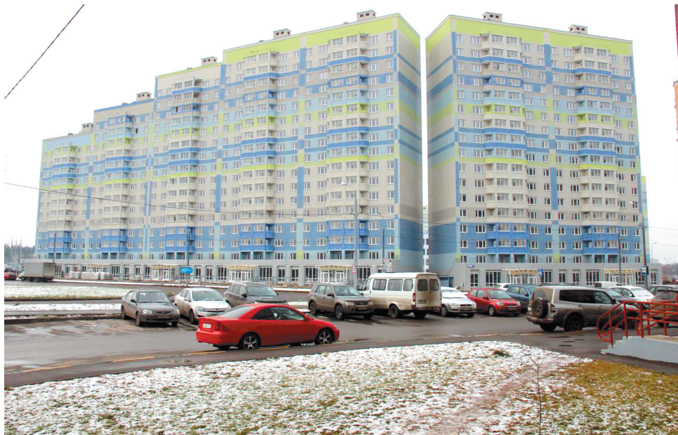
Дома в жилищном комплексе «Новые Ватутинки» (Москва) собраны из конструкций Алексинского комбината
