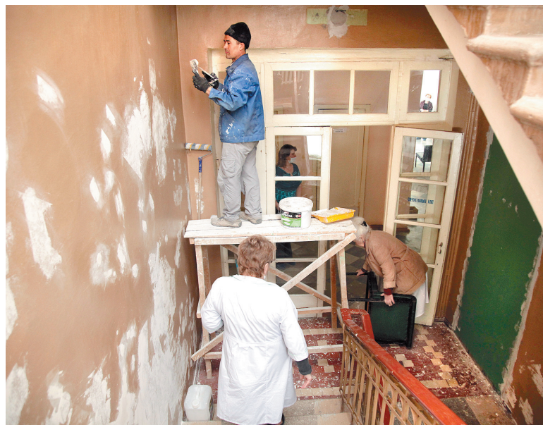
Сейчас в здании идет ремонт
