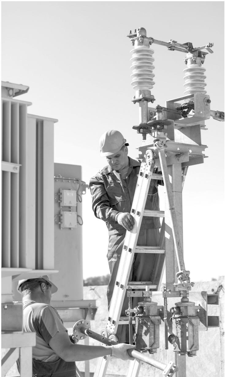
Возведение автомобильного завода на территории индустриального парка «Узловая» началось со строительства электроподстанции
