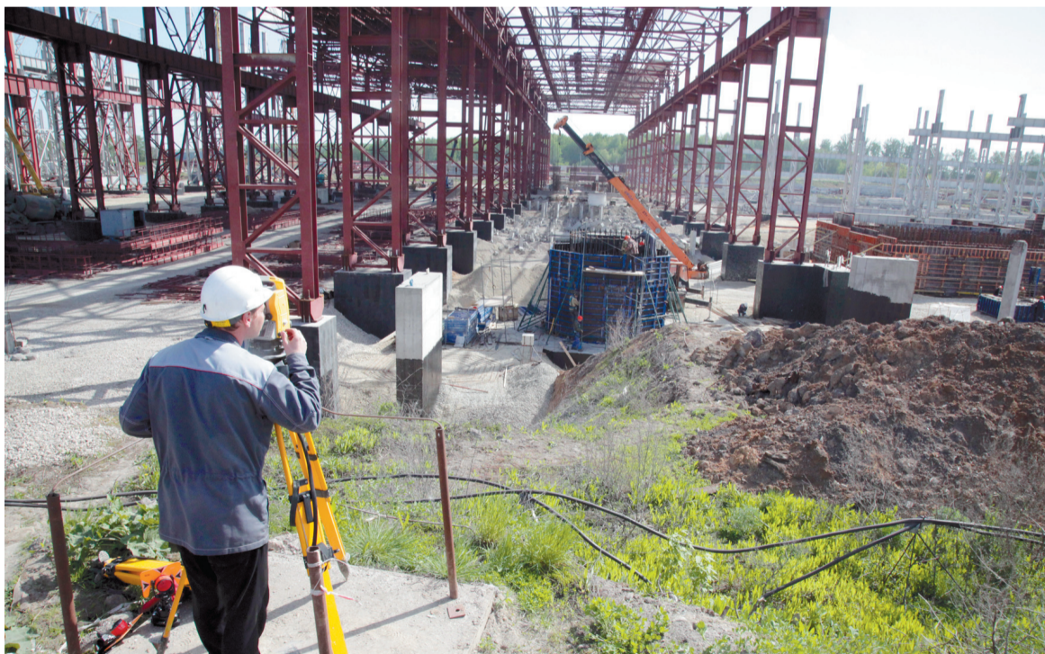
Литейно-прокатный комплекс растет вширь и ввысь с каждым часом, а скоро рабочих и техники тут станет еще больше
