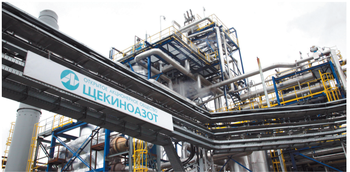
Постоянное обновление производственных мощностей – приоритет работы компании «Щекиноазот». Водородная установка В-26
