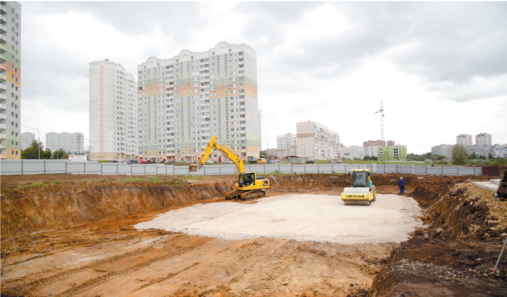
Строительство оставшихся пяти корпусов ЖК «Парус» уже началось, а завершение намечено на конец 2017 года
