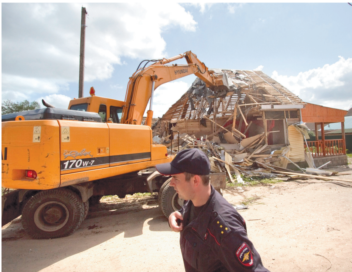
Дома, незаконно возведенные в Плеханово, будут снесены. И это не обсуждается
