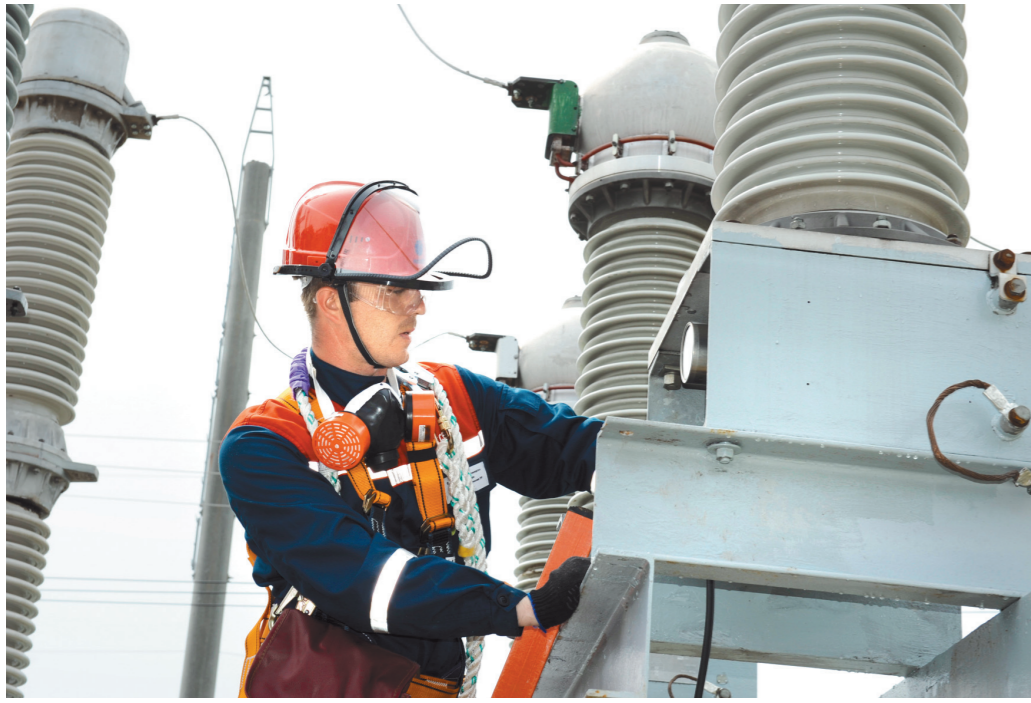
Прохождение этапа по ремонту трансформатора тока
