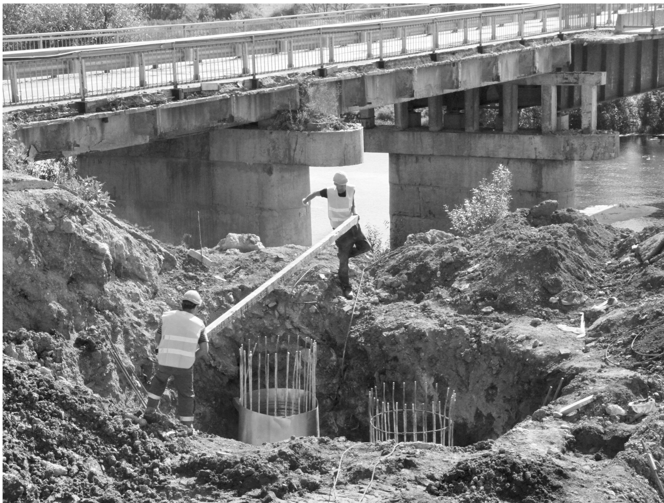
Строительство нового Иноземского моста началось месяц назад. Уже установлены сваи, которые послужат основанием бетонных опор.
