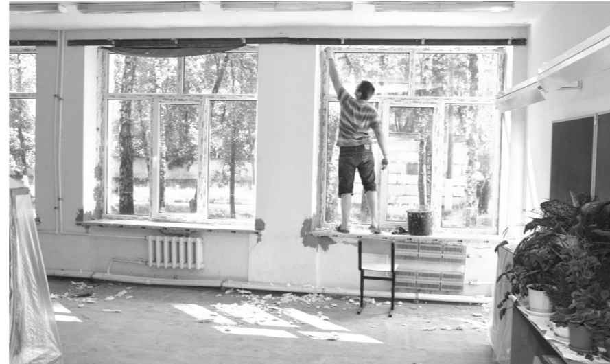
В 848 учреждениях провели ремонт по 953 позициям
