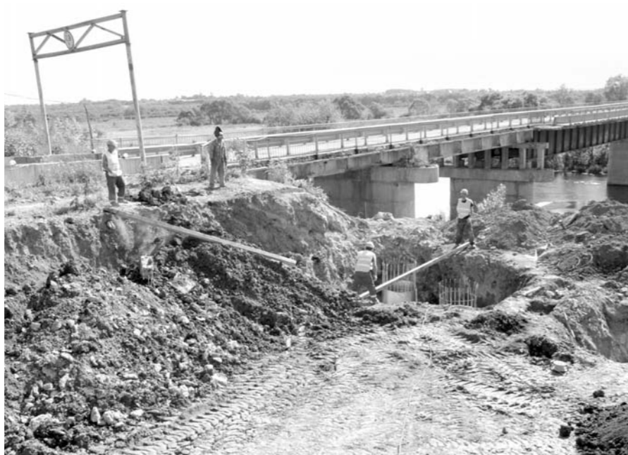
Мост через Красивую Мечу в Ефремове приведут в порядок к июлю 2018 года
