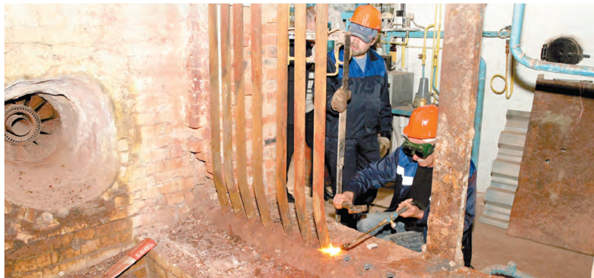
Все лето в котельных региона шли подготовительные работы к отопительному сезону – 2017/2018
