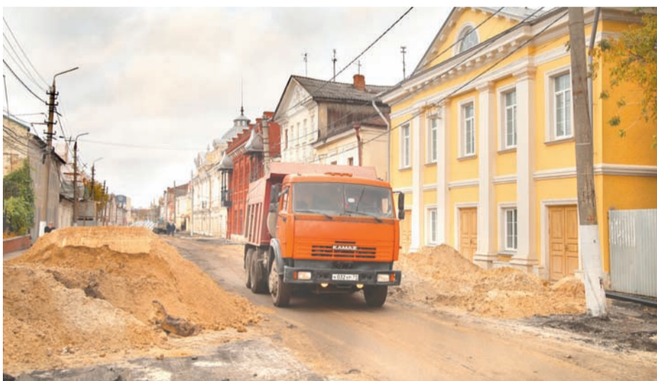
Улицу Металлистов на следующей неделе ждет перекладка газовых сетей
