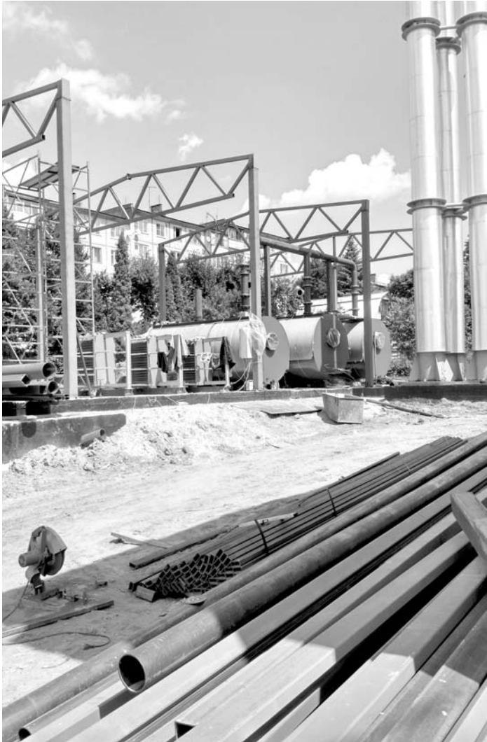
В Черни в этом году компания-концессионер установила две модульные котельные взамен трех старых и проложила более 4,5 километра труб
