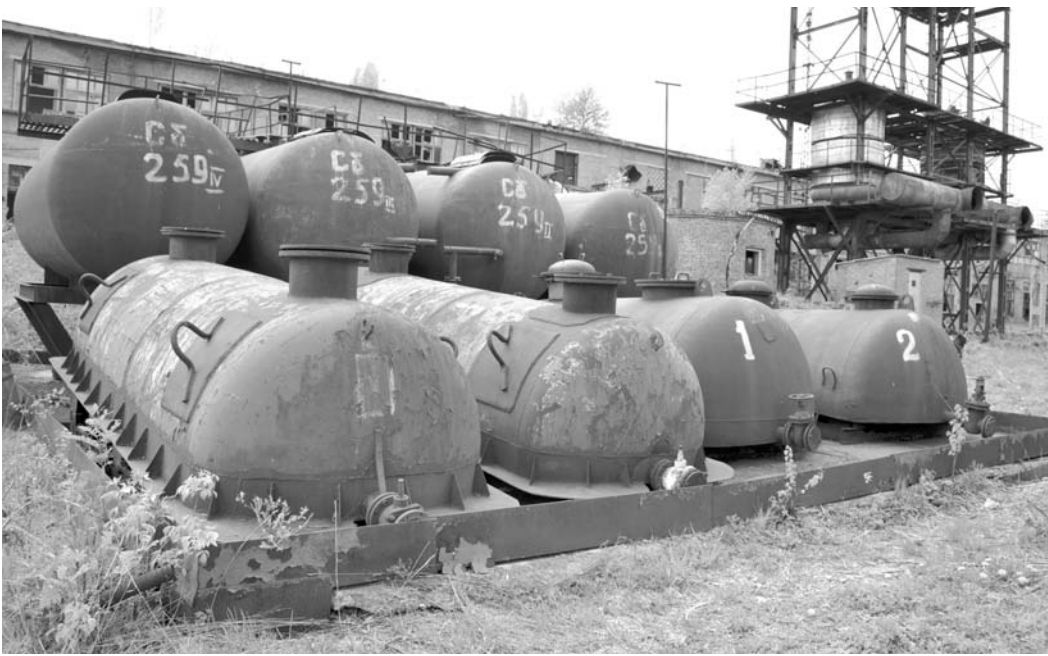
Опасные отходы хранились вот в таких металлических контейнерах
