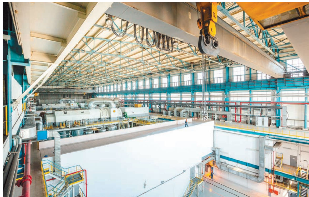
Турбинное отделение блоков 225 МВт котлоагрегатного цеха
