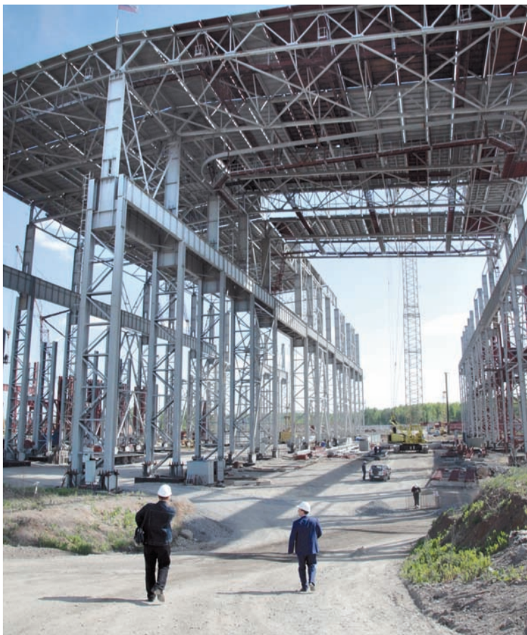
Пусконаладочные работы в ООО «Тулачермет-Сталь» начнутся в конце 2017 года
