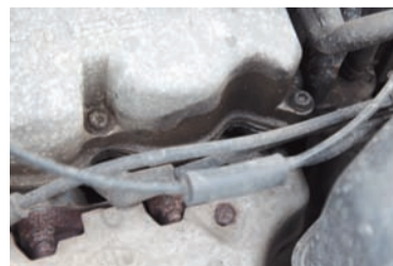
Прокладка клапанной крышки под замену
