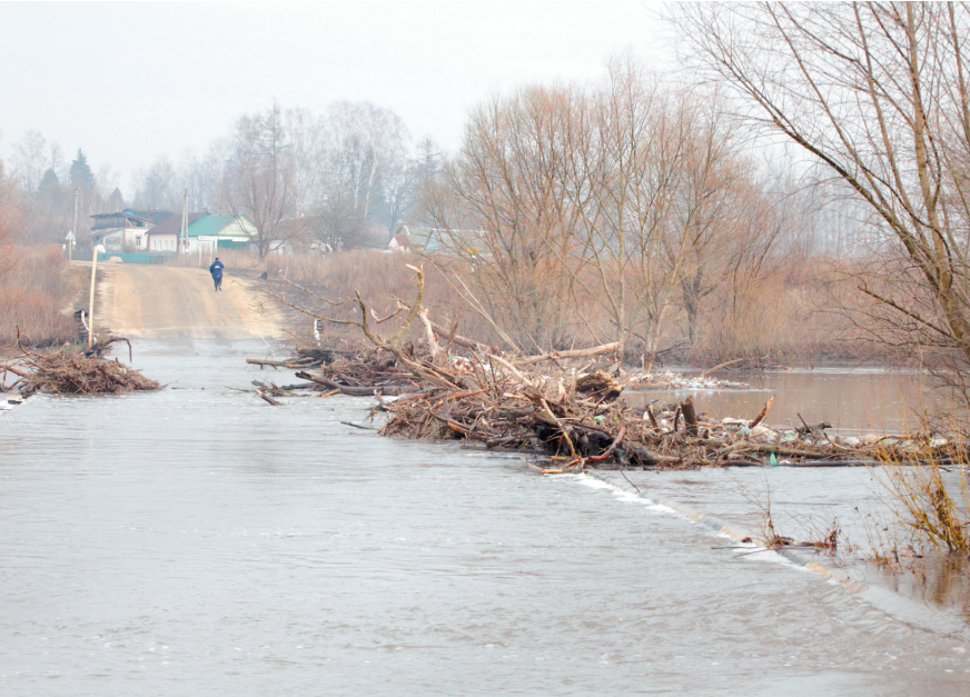
Затопление переправ происходит в нашем регионе практически каждый год
