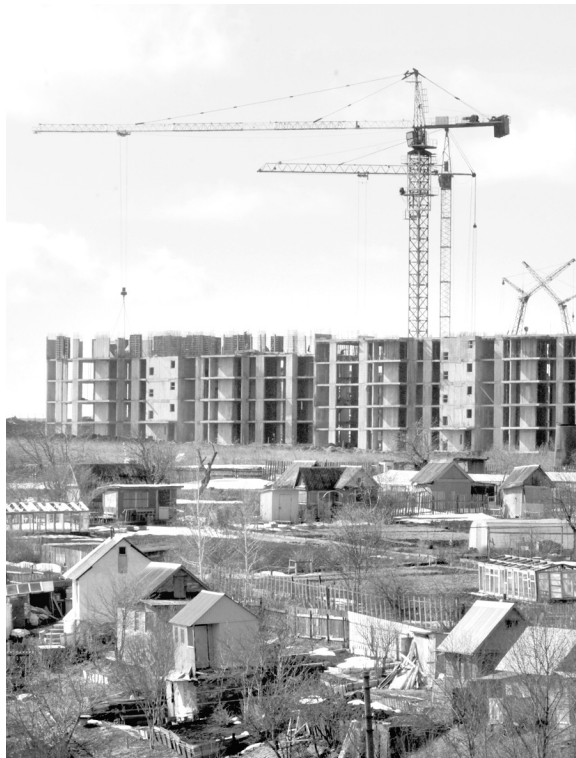
Так сейчас выглядит одна из строительных площадок в Киреевском районе
