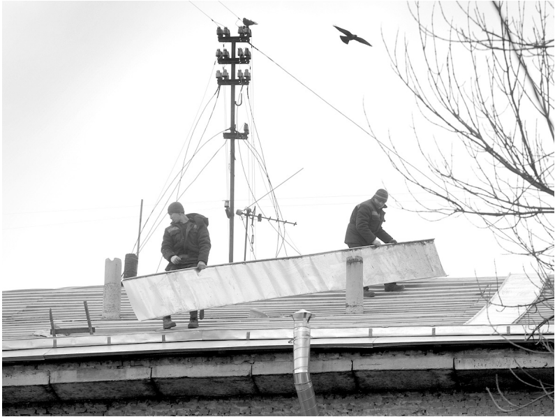
Ремонт крыши дома № 18 идет полным ходом
