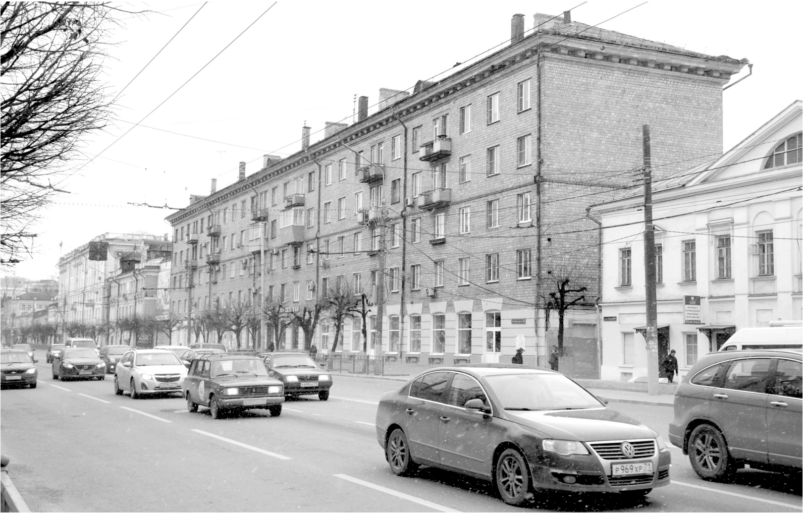
Капремонт сделает дом надежным внутри и красивым снаружи
