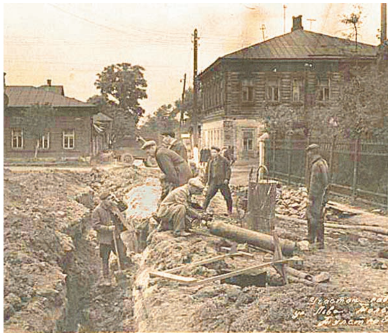
Укладка газопровода на улице Льва Толстого в Туле
