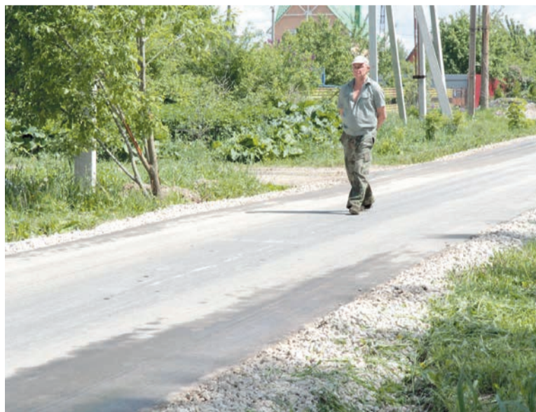
На улице Строителей уложили 2230 квадратных метров асфальта
