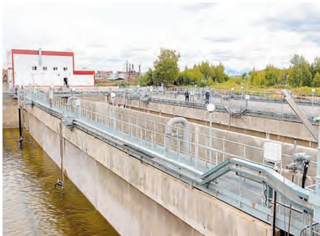
Новые очистные сооружения
