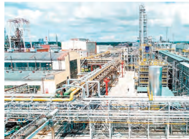
Совмещенный комплекс метанола и аммиака
