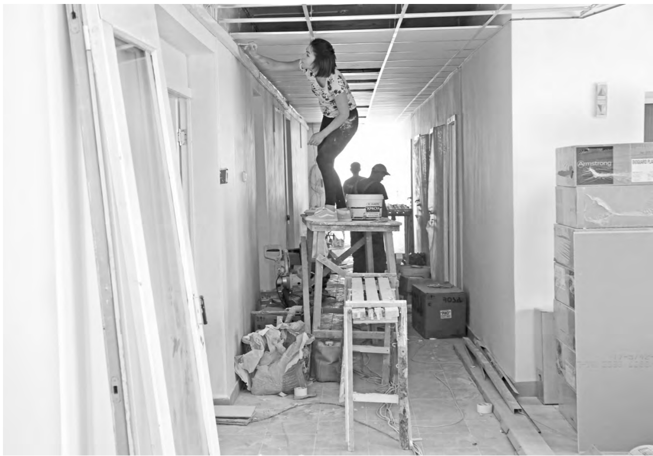
Ремонт идет сразу на двух этажах
