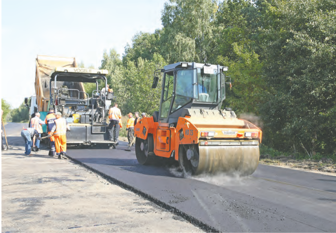
Строительство новых дорог позволит снизить нагрузку на уже существующие магистрали
