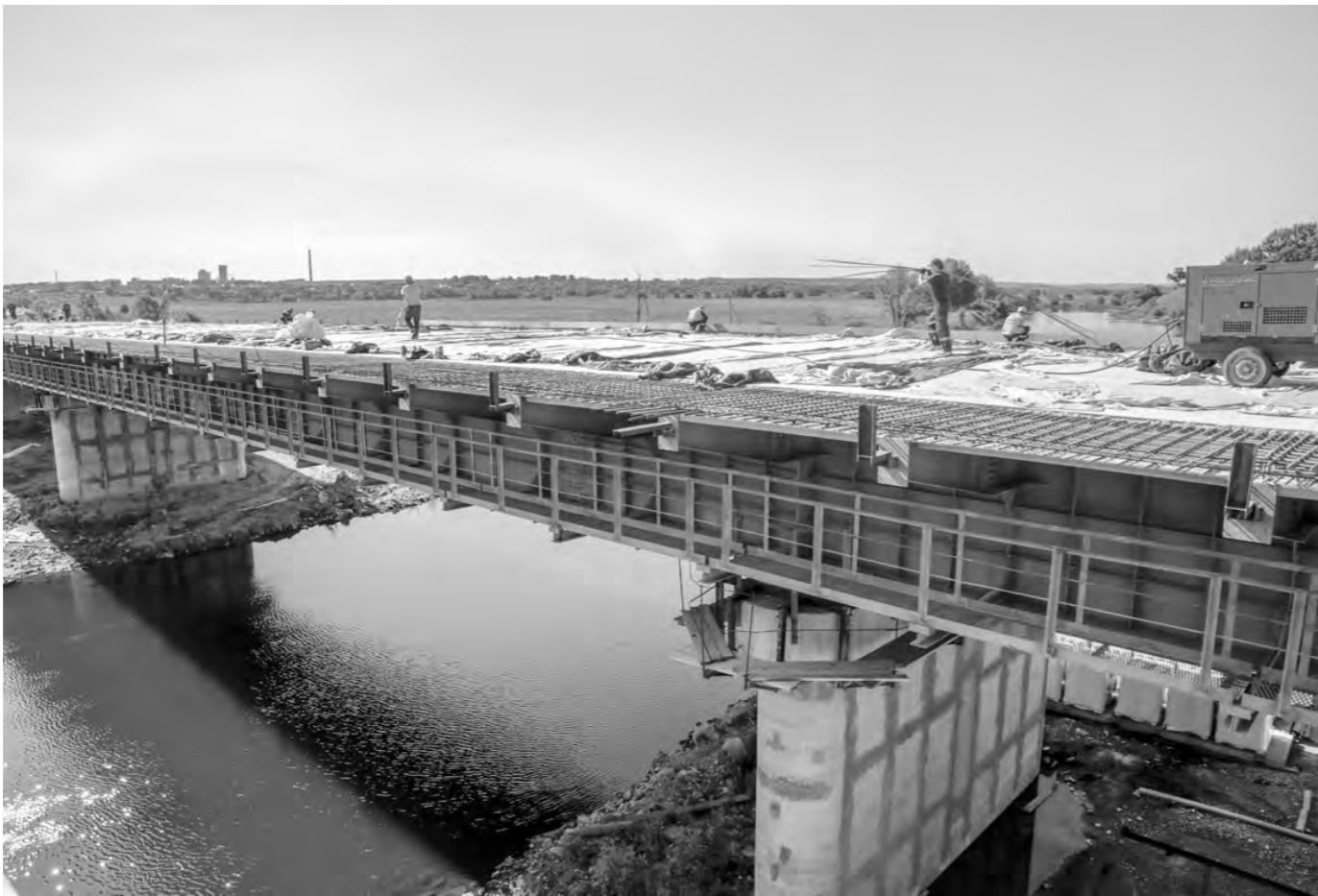
Возведение моста в Ефремове – на особом контроле регионального министерства транспорта и дорожного хозяйства
