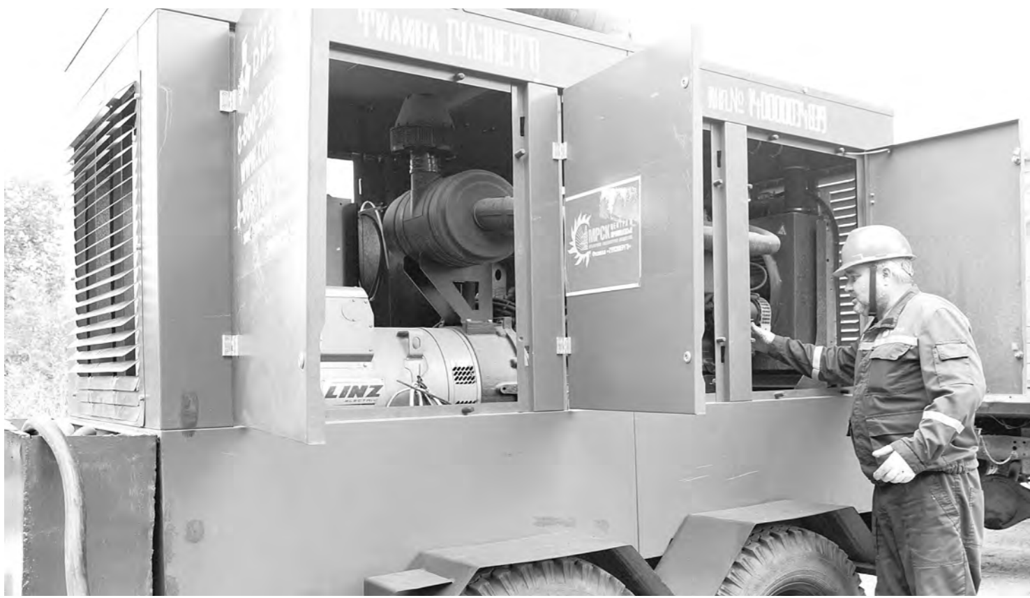
← Подготовка дизель-генератора к работе
