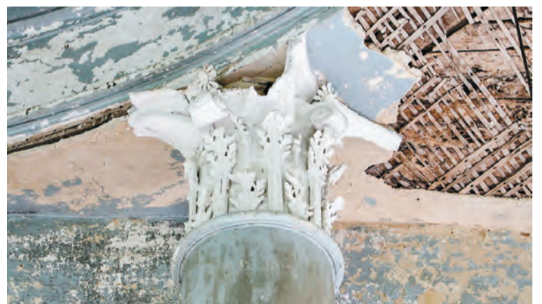
Внутри сохранились элементы богатой лепнины
