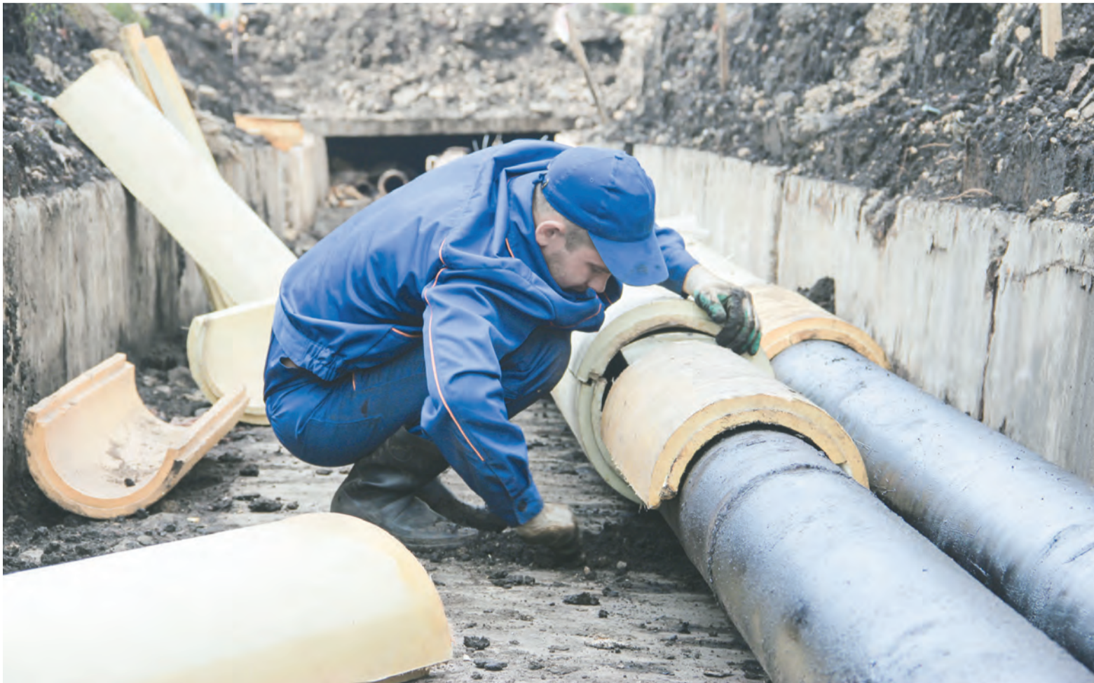
В Туле ведется активная работа по обновлению ветхих коммунальных сетей
