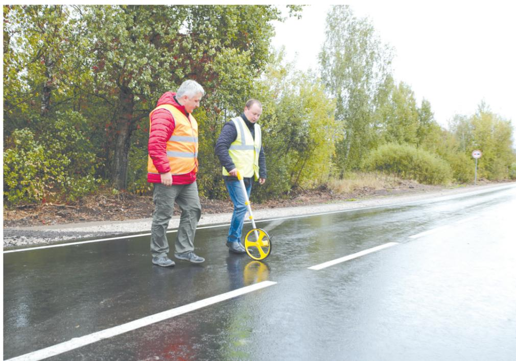
С помощью курвиметра дорожники определяют ширину полотна
