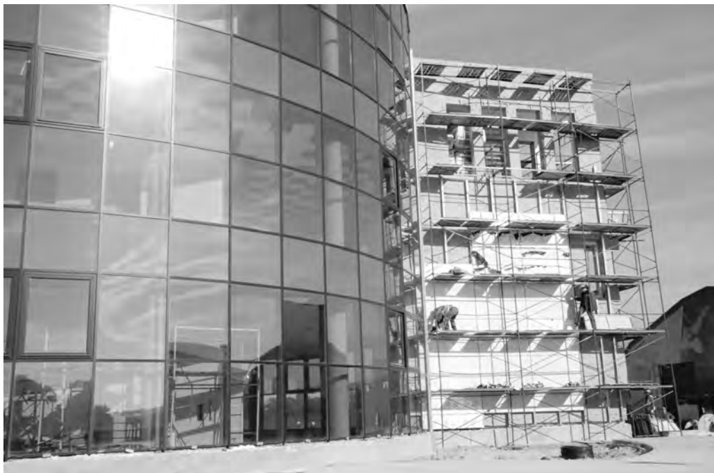
Строительные работы вышли на финишную прямую
