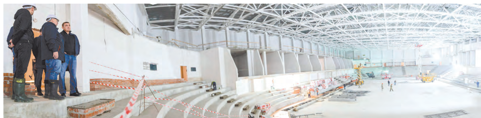
Алексей Дюмин проинспектировал строительство Ледового дворца в Туле
