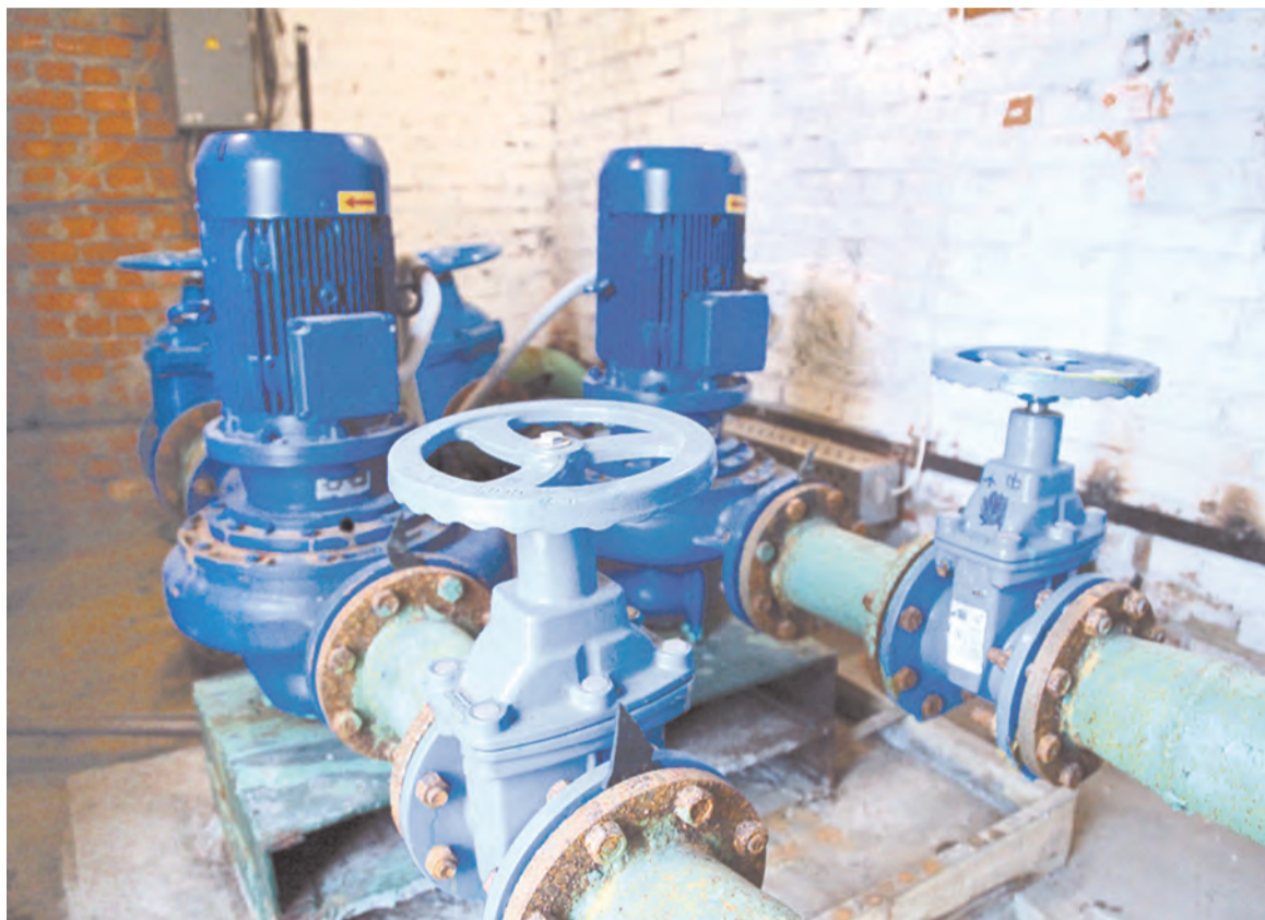
На станции установлены два насоса и...
