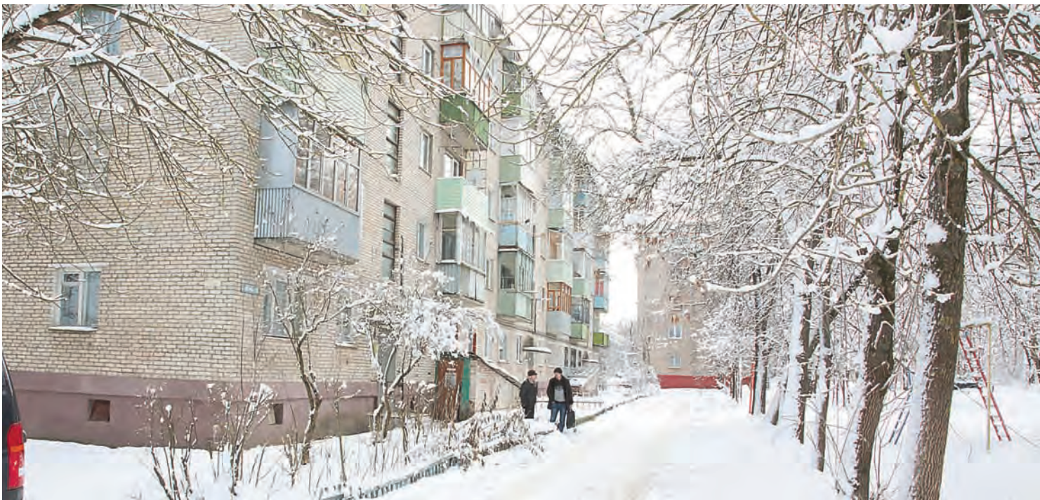
Справа от этой пятиэтажки планируется построить котельную, которая станет снабжать горячей водой микрорайон Соцгород
