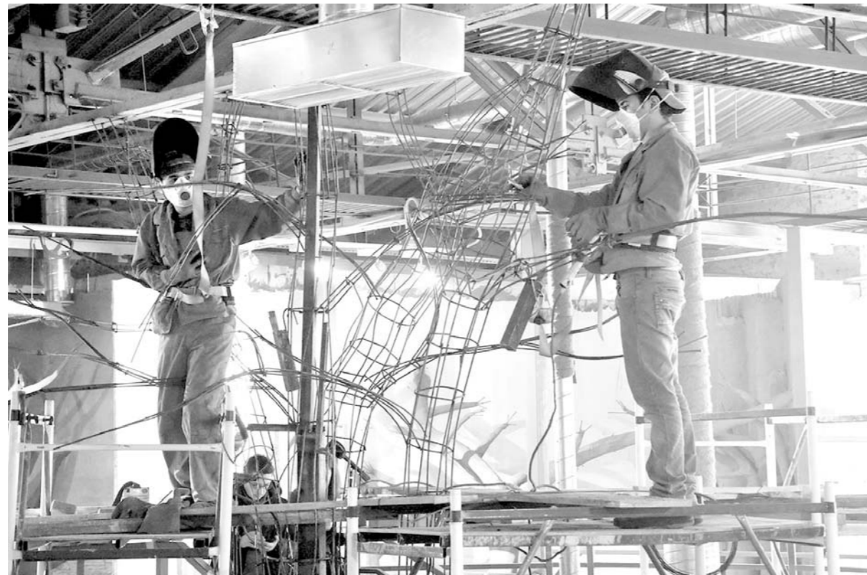
Сейчас внутри активно ведутся сварочно-монтажные работы
