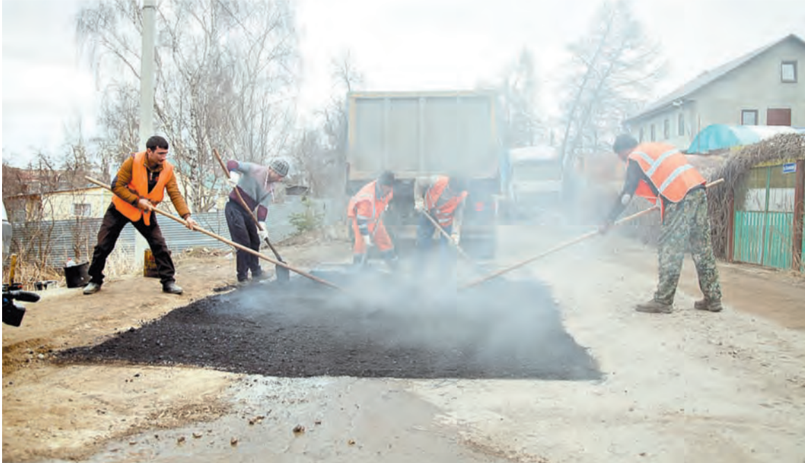
В Туле стартовали работы по ремонту дорог горячим асфальтом
