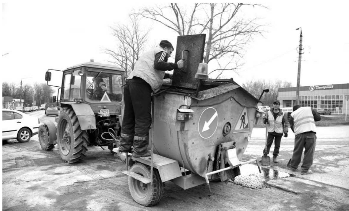
Дорожный ремонт на улице Октябрьской в Донском
