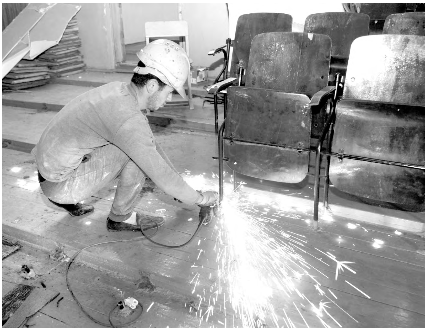
Сейчас в щекинской школе искусств ведется ремонт
