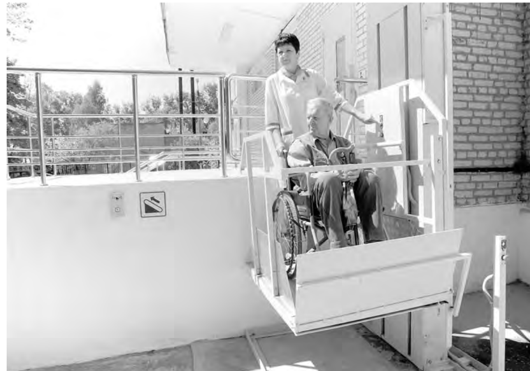
Подъемник-платформа в работе
