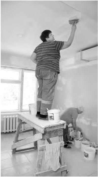
На втором этаже потолки и стены уже готовят к покраске
