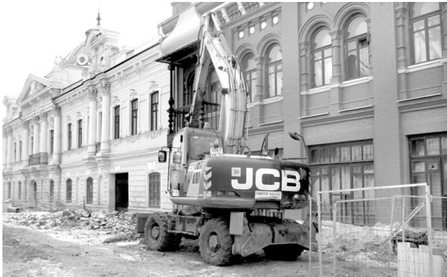
Реконструкция улицы Металлистов ведется без выходов
