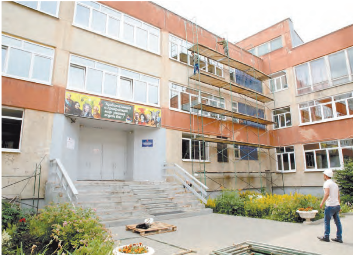
В центре образования №27 ремонтируют фасад по «Народному бюджету»
