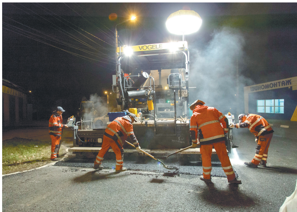
15 октября, Веневское шоссе. Строители работают ночью, чтобы не создавать проблем автомобилистам
