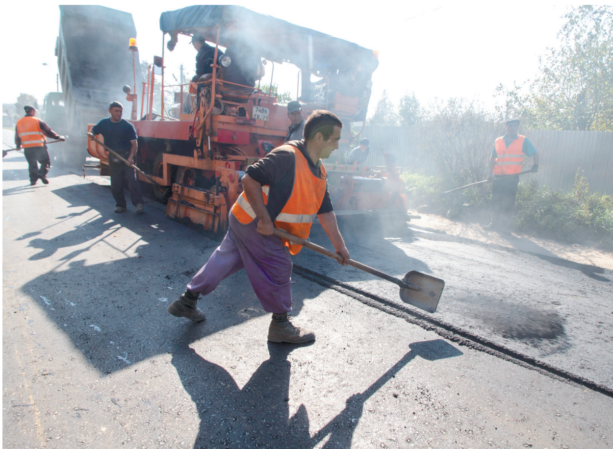
На строительстве магистрали
