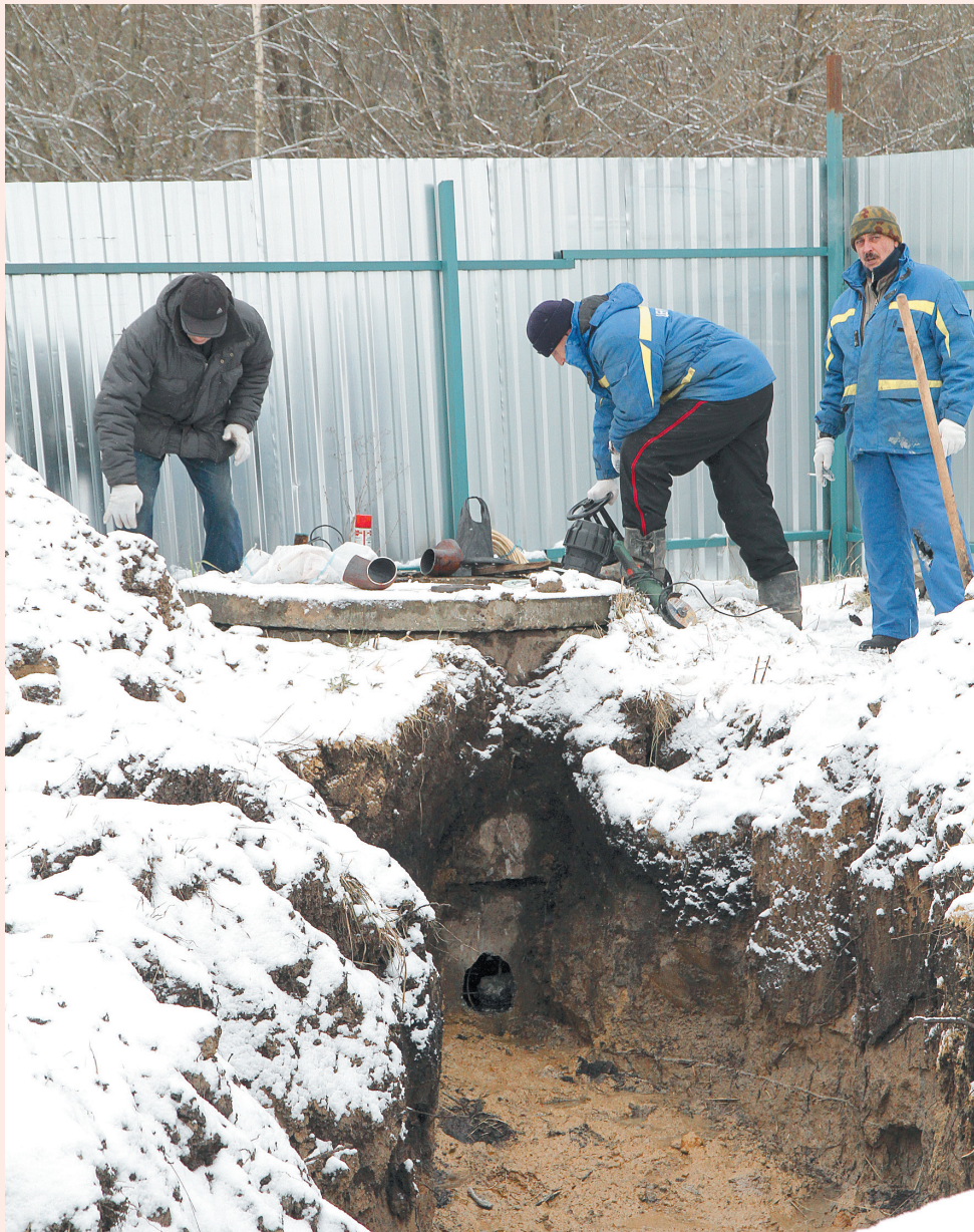
Нужно соединить коммуникациями скважину с магистралью, установить запорную арматуру в колодцах. Один колодец уже привели в порядок, на очереди другой
