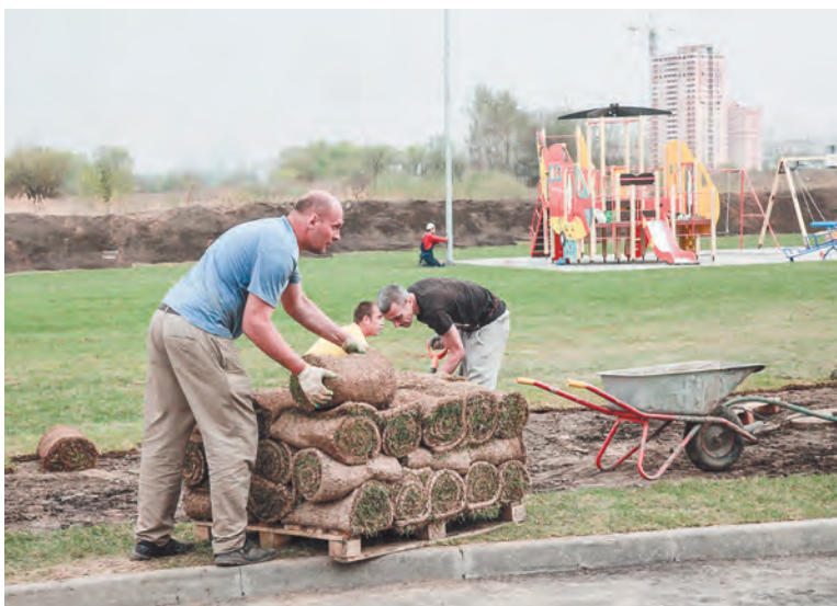
На территории парка укладывают газон
