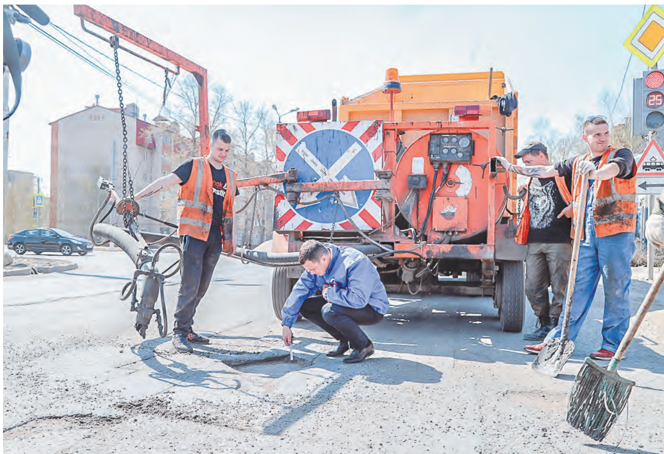
Ремонт дороги ведется методом пневмонабрызга
