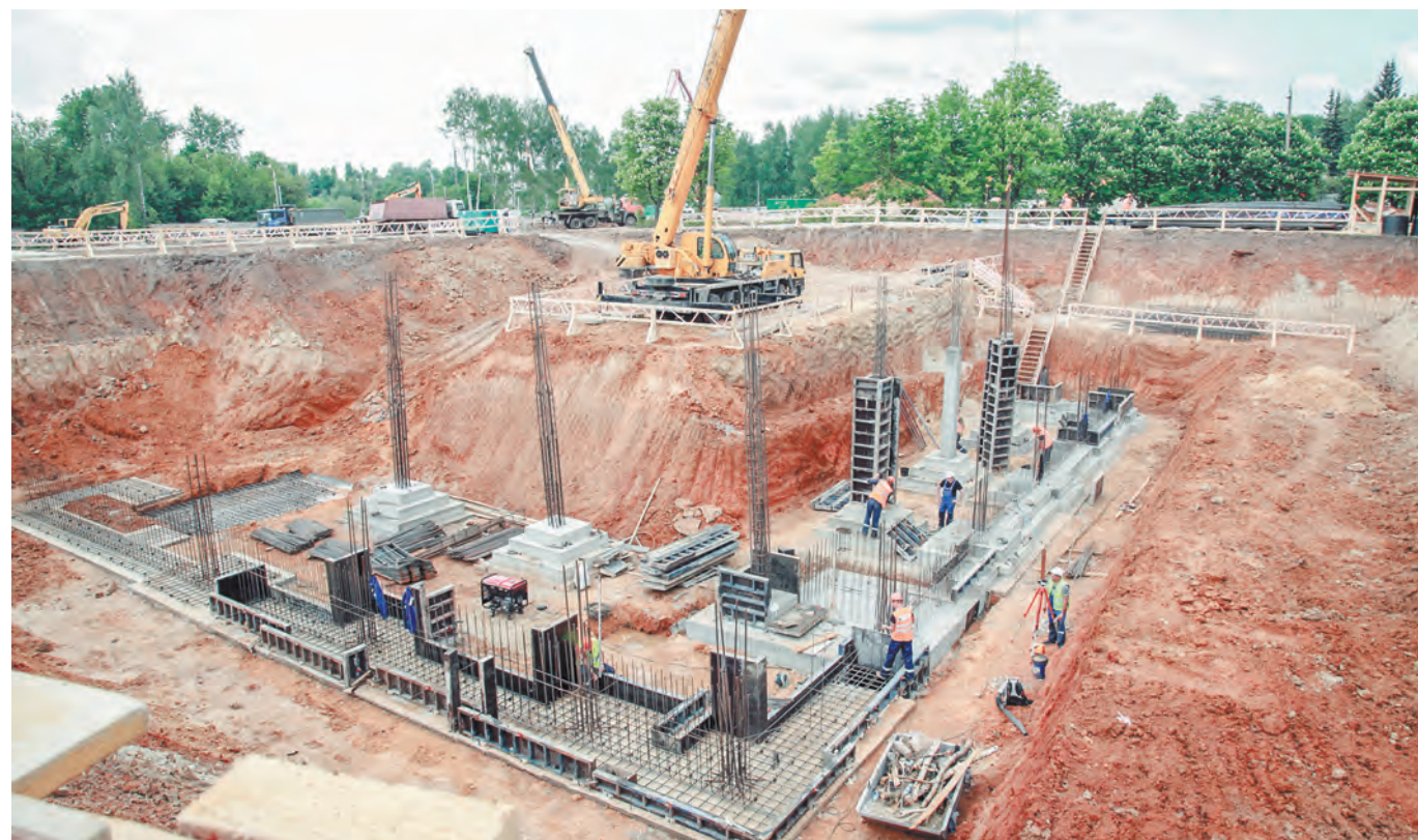
Контур будущего здания уже просматриваются
