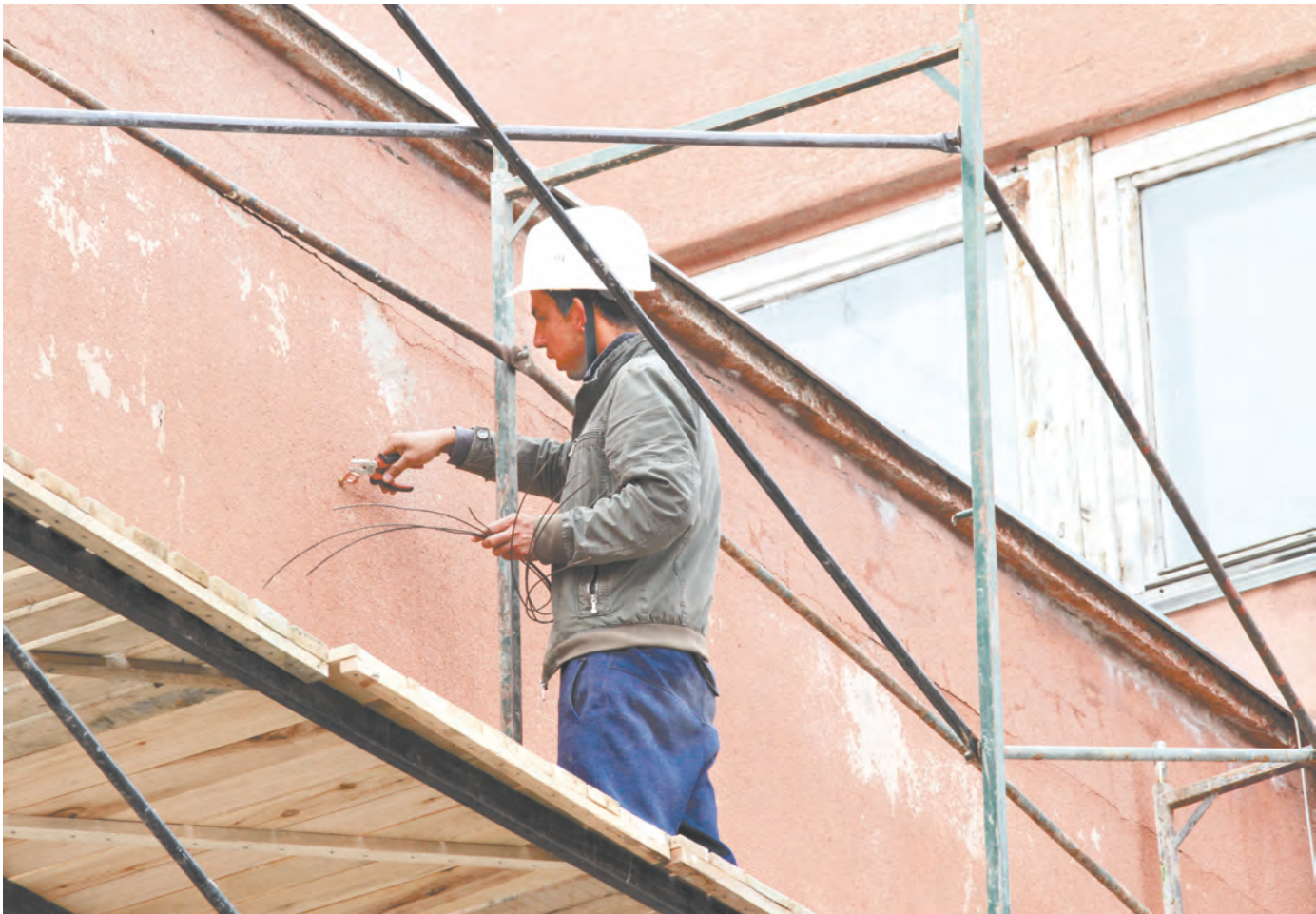
Капремонт проводится по различным видам работ, затрагивающих инженерные коммуникации, кровлю, фасады домов
